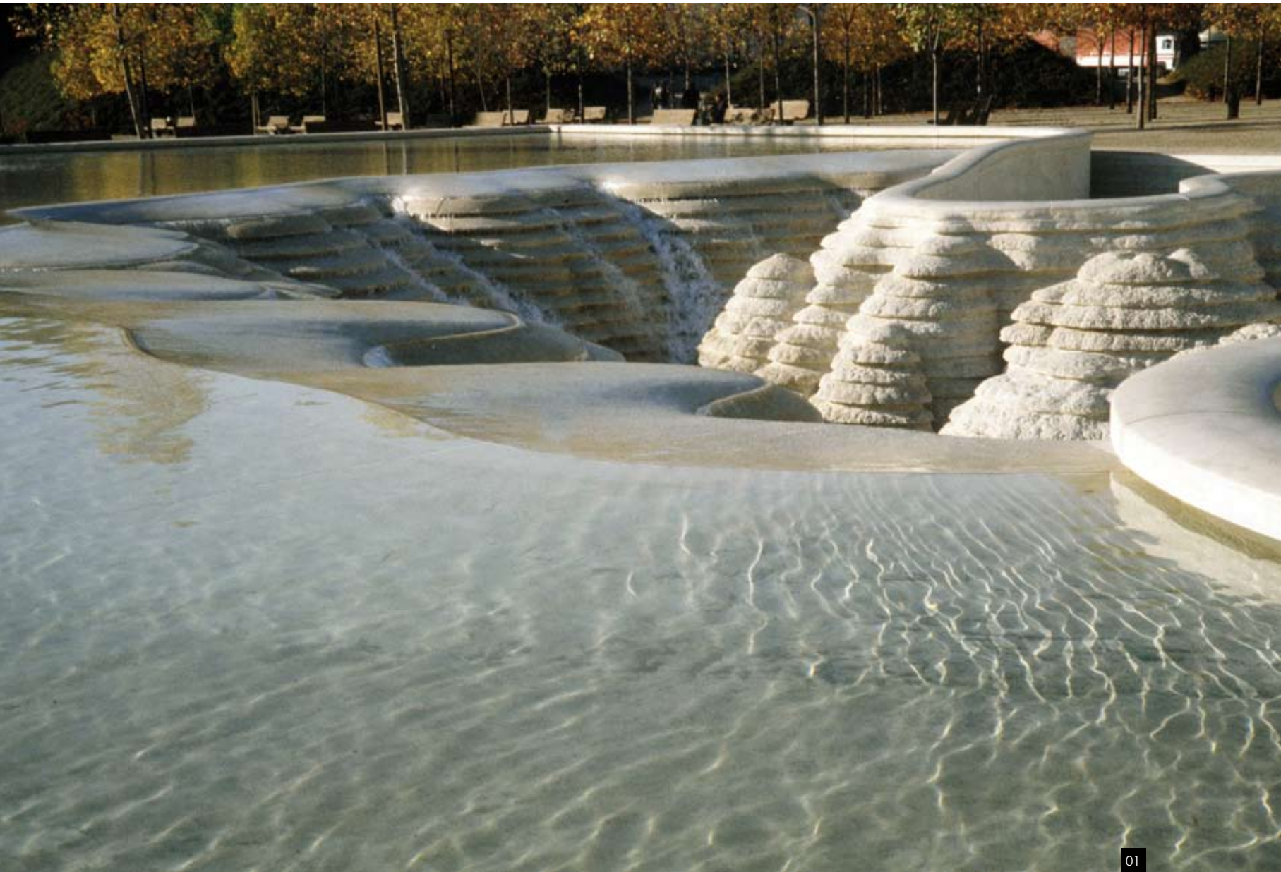
01. Le grand bassin fonctionne en débordement et se déverse dans le Canyon 01. The large basin is designed to overflow, pouring its contents into the Canyon
